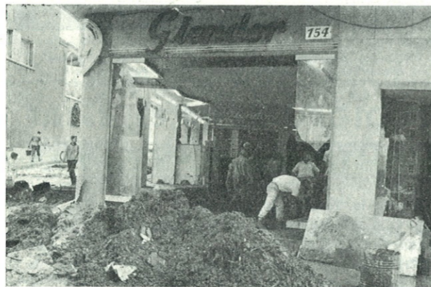
Las instalaciones de este establecimiento, recién inaugurado, fueron arrasadas por las aguas. Reconstruido de nuevo, a las pocas semanas una nueva riada las volvió a destruir.
