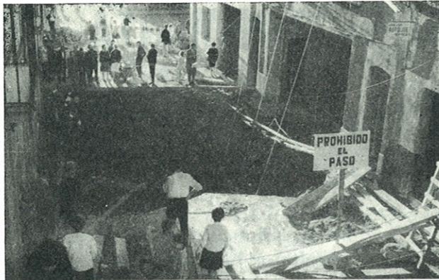
Socavón en la calle Cervantes, una de las más céntricas de Tarrasa. (Foto Altimira.)
